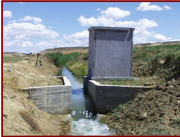
Estación de aforo, limnógrafo y muestrador automático de aguas
